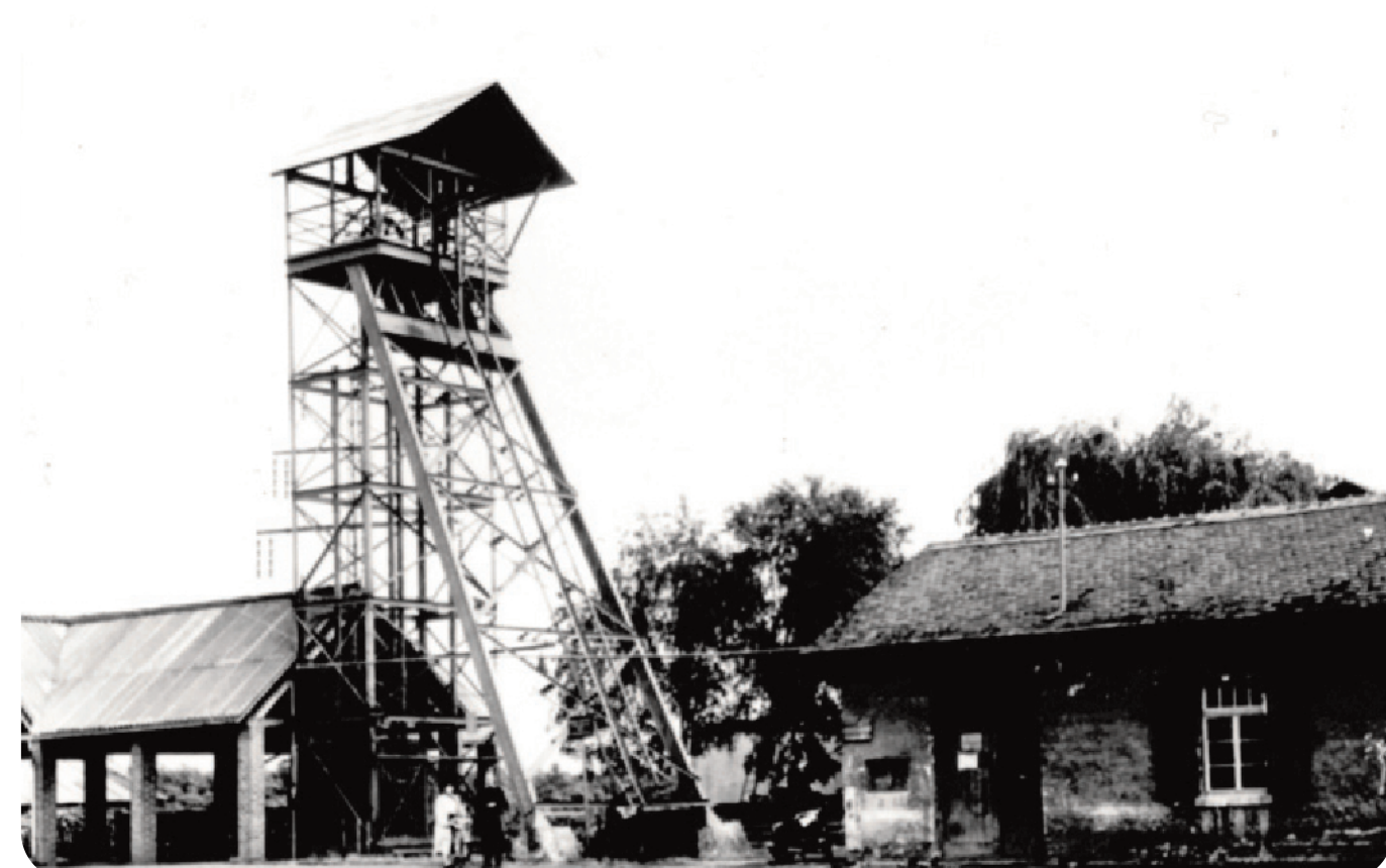
Alfredschacht von Norden gesehen, um 1953 links: Aufbereitung und Erzbunker, rechts: Maschinenhaus ("Haspelhaus")
