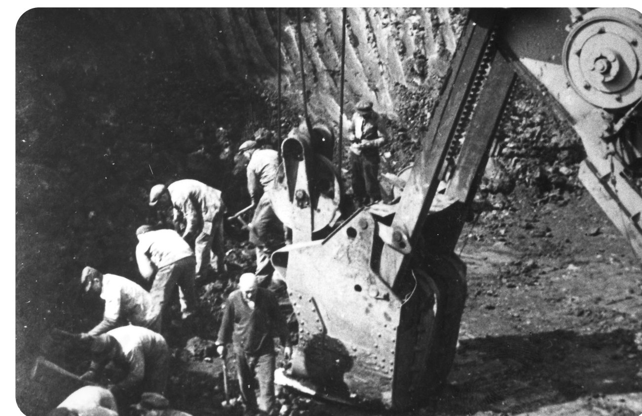
Elektrobagger im Tagebau Feldwiesen (umrüstbar auf Schürfkübel), um 1952
