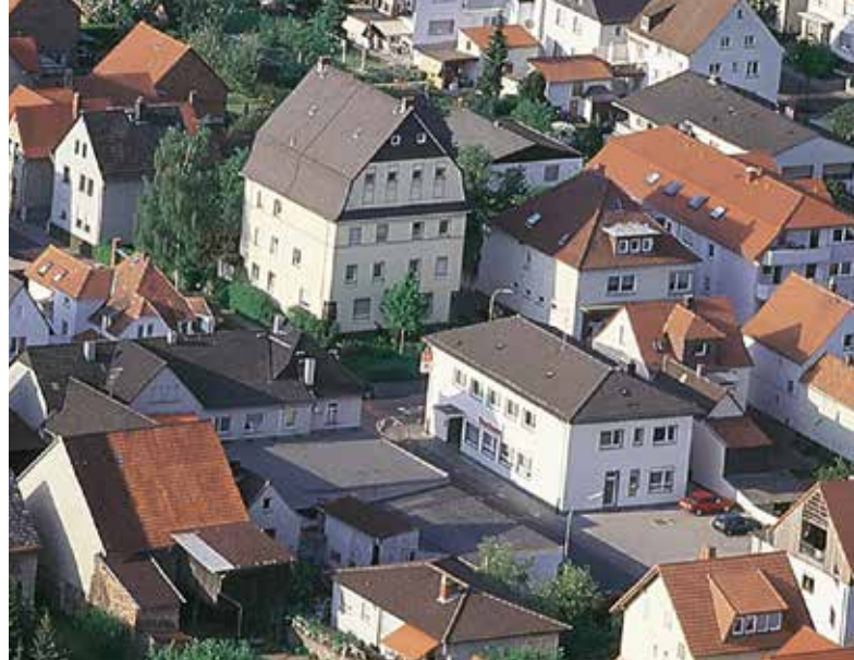
Luftaufnahme „Wasserhaus und Umgebung“ in Großen-Linden
