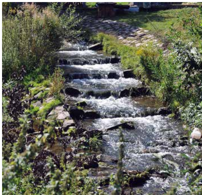
Die Fischtreppe im Kleebach hinter der Mühle in der Frankfurter Straße
